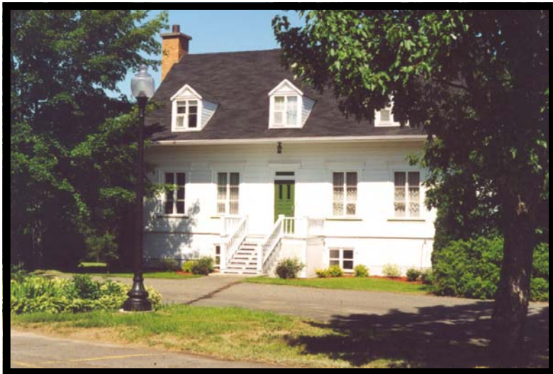
Maison Desrochers qui a servi d'évêché de 1951 à 1957 (Archives du diocèse de Sainte-Anne)
